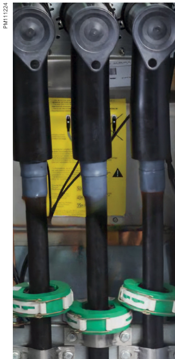
Stromsensoren werden vor Ort an einadrigen Kabeln montiert
